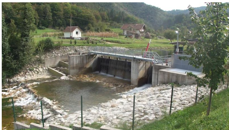
Slika 2.1.-28: Vodozahvat za mHE „Čardak“
