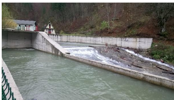
Slika 2.3.-20: Vodozahvat mHE „Voljevac“
