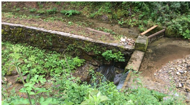
Slika 2.1.-1: Vodozahvat na VT Jasenovac
