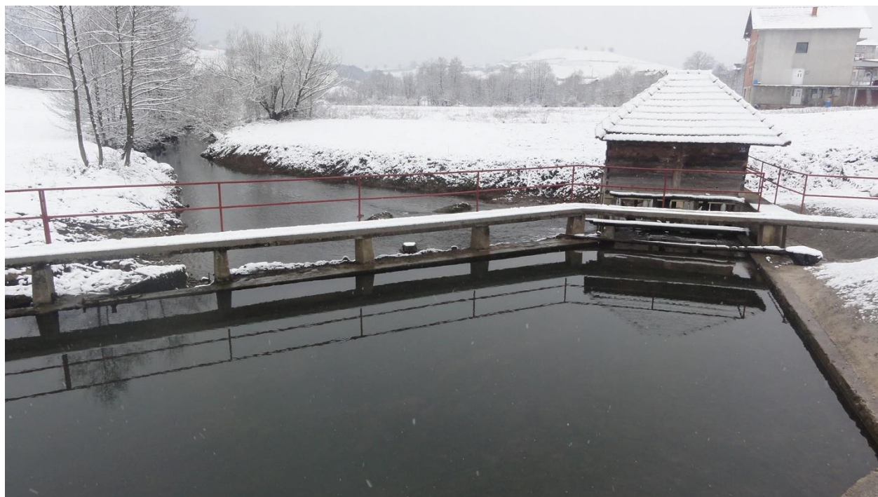
Slika 2.2.-1: Vodozahvat za vodenicu na rijeci Kladašnici
