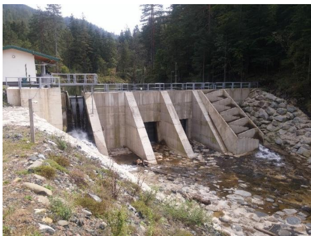
Slika 2.1.-26: Vodozahvat za mHE „Botašnica“
