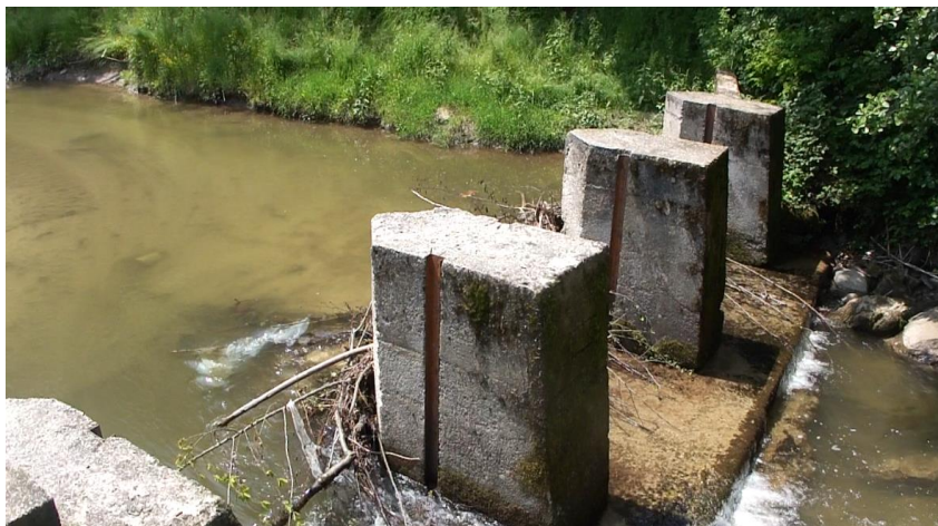
Slika 2.1.-19: Betonska konstrukcija na VT Kruščica-Tromošnica
