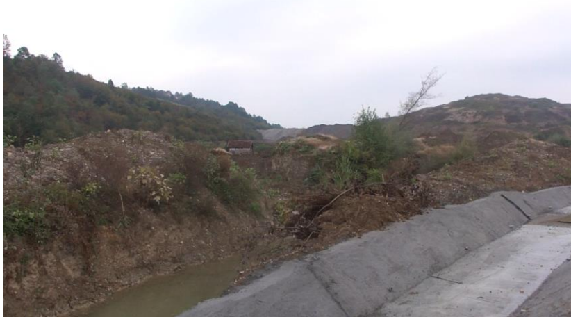
Slika 2.1.-9: Dovodni kanal na VT Turije
