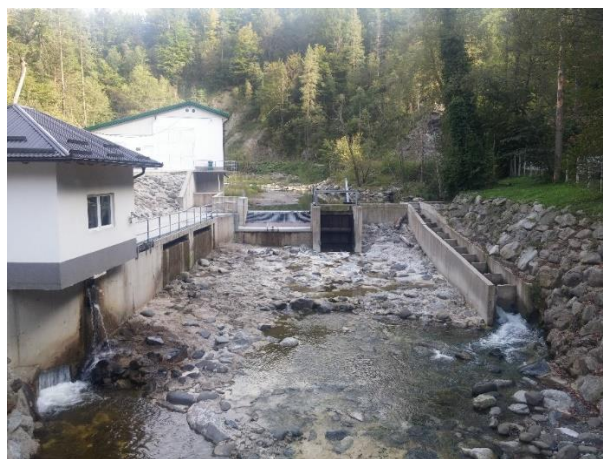
Slika 2.1.-27: Vodozahvat za mHE „Rujevica“
