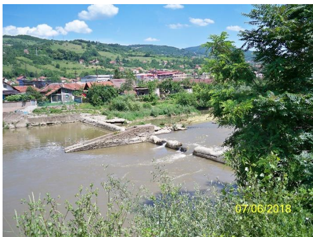
Slika 2.1.-4: Vodozahvat na VT BA_BOS_4
