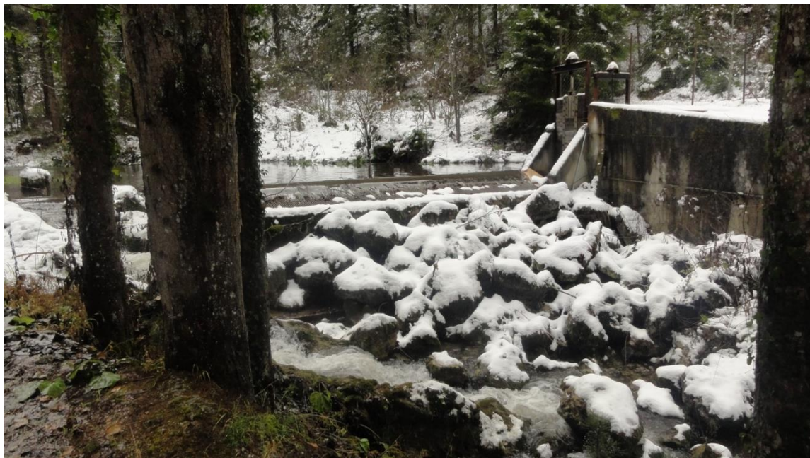
Slika 2.3.-23: Vodozahvat mHE „Prusac 1“
